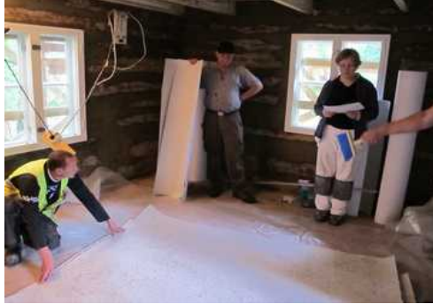
Pinkopahvitusta ohjataan. Hirsiseinä on tiivistetty ja tasattu savirappauksella
